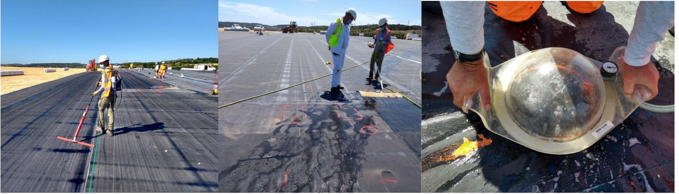
Figure 5. Méthodes de l'arc électrique, de la flaqué d'eau et de la cloche à vide, de gauche à droite (in Cazeaux et al, 2022)
